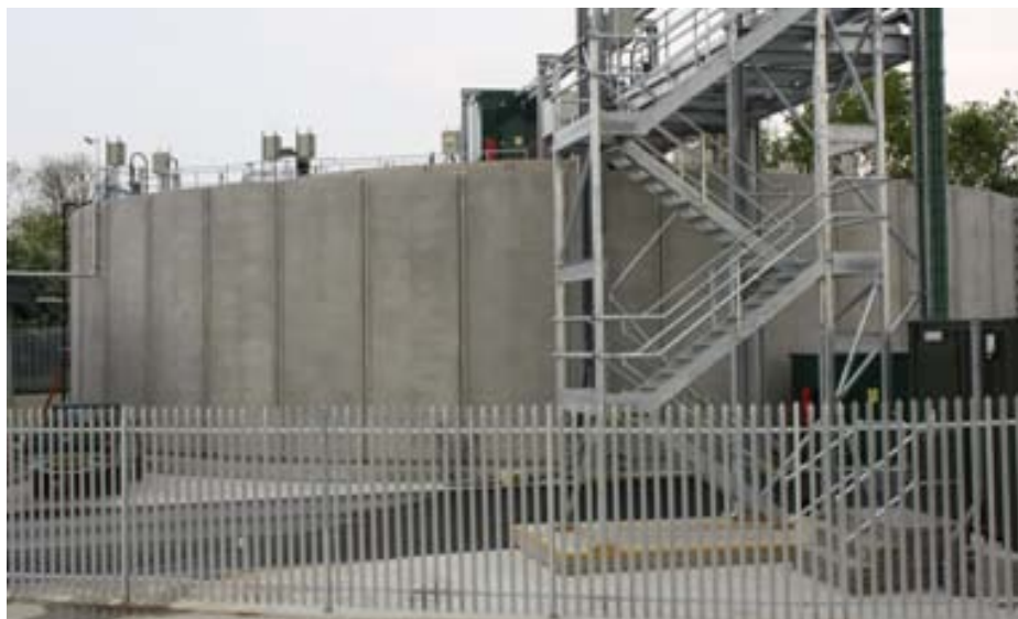
Pared del tanque, donde se aprecia la construcción a base de segmentos de hormigón.
